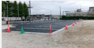
【運動場駐車場】
