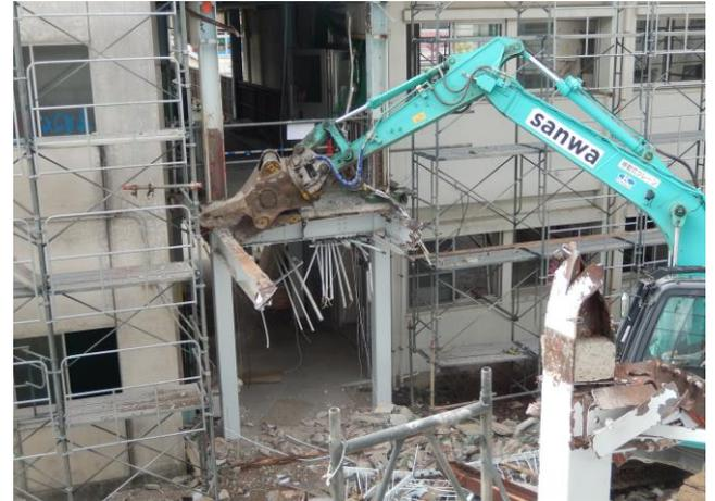
大きな重機が、鉄骨を切るように解体しています。
